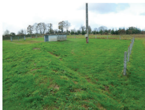
▲ Captage d'eau potable : Aménagement de terrain
